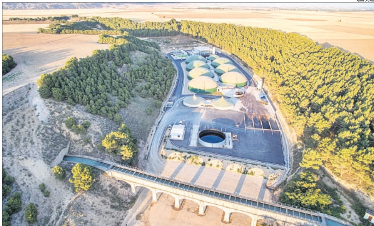
En la imagen, la planta de biogás de Almenar, donde el Grupo Griñó genera energía verde con procesos como la digestión anaerobia.
