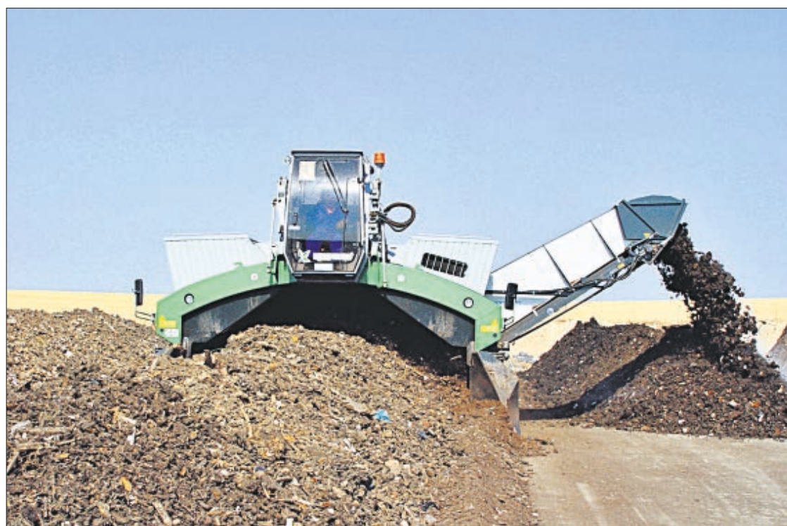
Maquinaria trabajando en la planta de compostaje de Alguaire del Grupo Griñó.
